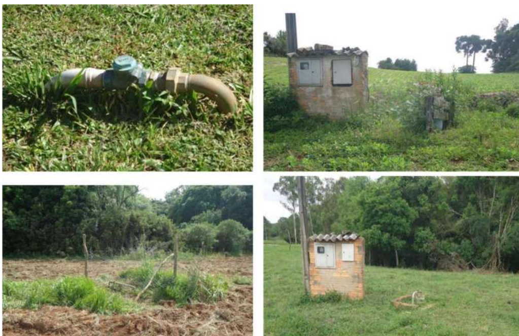
Figura 19. Condições atuais do sistema de captação e tratamento de águas da área rural
