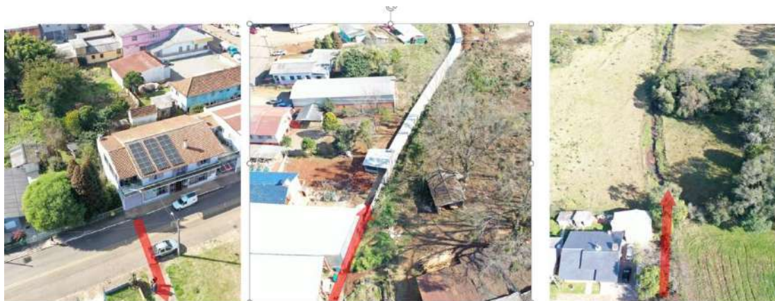
Figura 34. Imagens do córrego canalizado e seu ponto de saída
