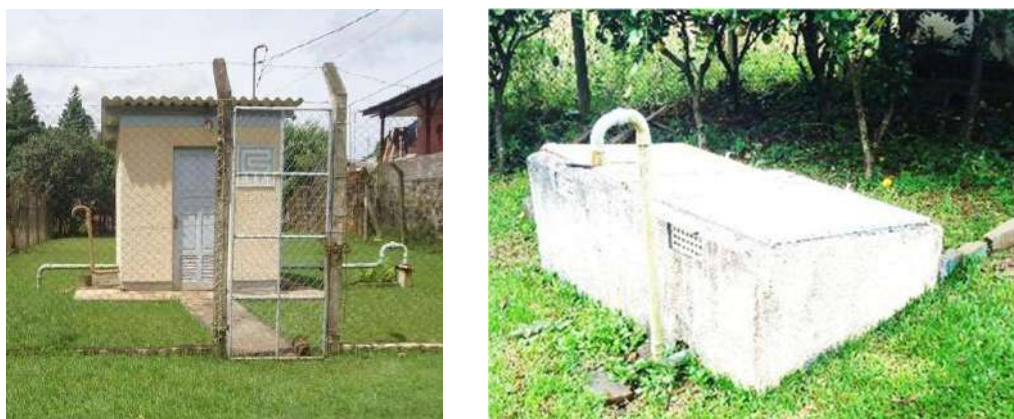
Figura 17. Imagens dos poços 1 e 2 da CORSAN
