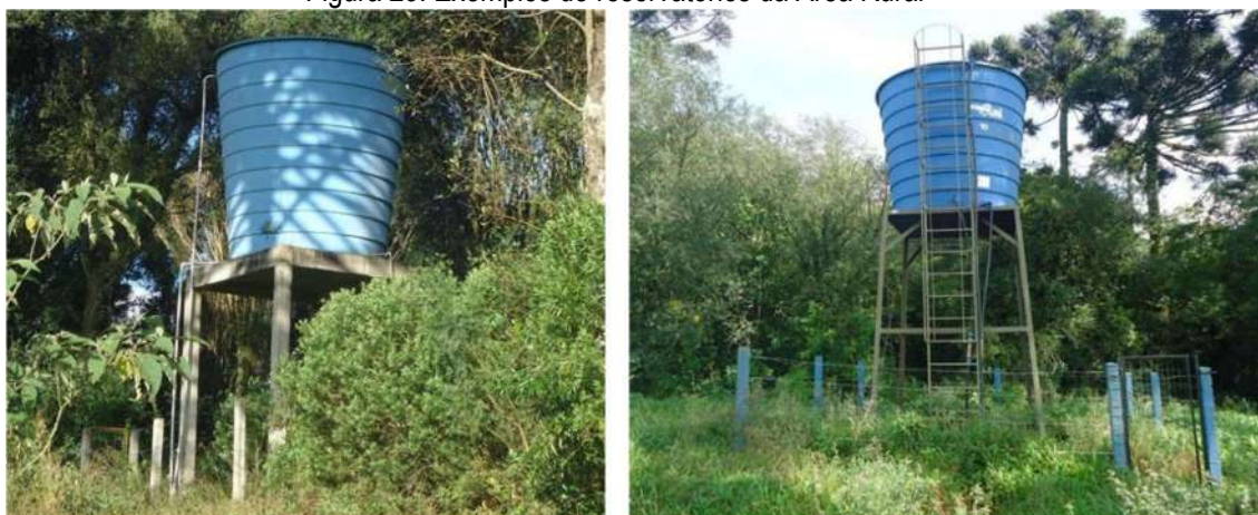
Figura 23. Exemplos de reservatórios da Área Rural
